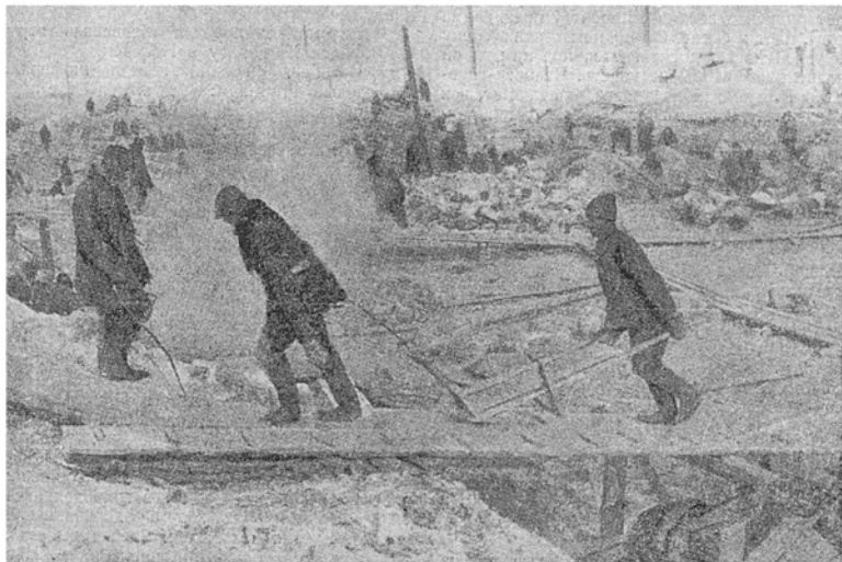
15. Начало работ (с. 75)
